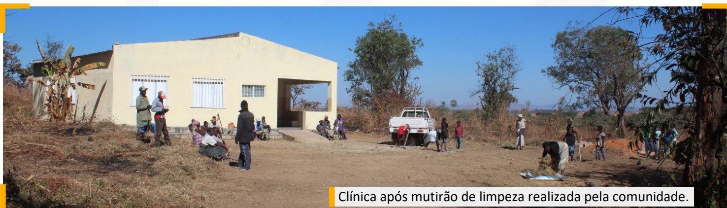
Vista da clínica antes da reforma, logo após as ruínas.
